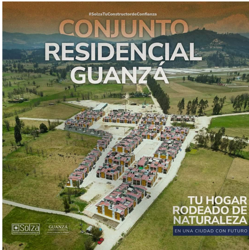
Figura 3. Avance de obra al 2024
