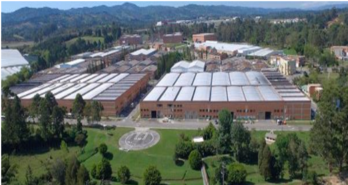
Ilustración 9. Zona Franca desde el exterior
