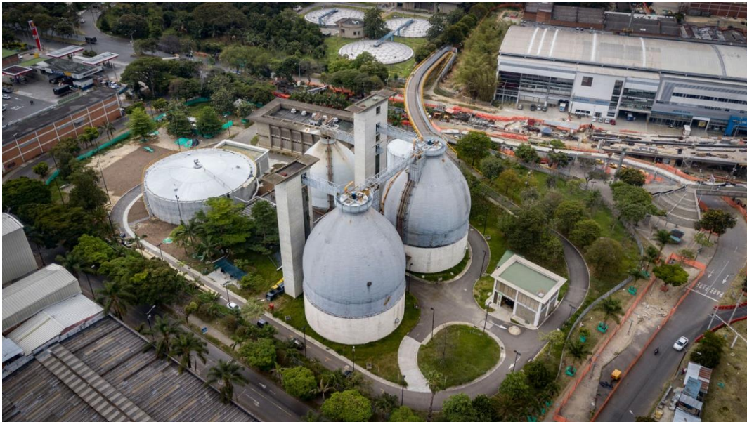
Figura 1. Biodigestores de la Planta de Tratamiento de Aguas Residuales San Fernando (Tomado de página web de EPM)
