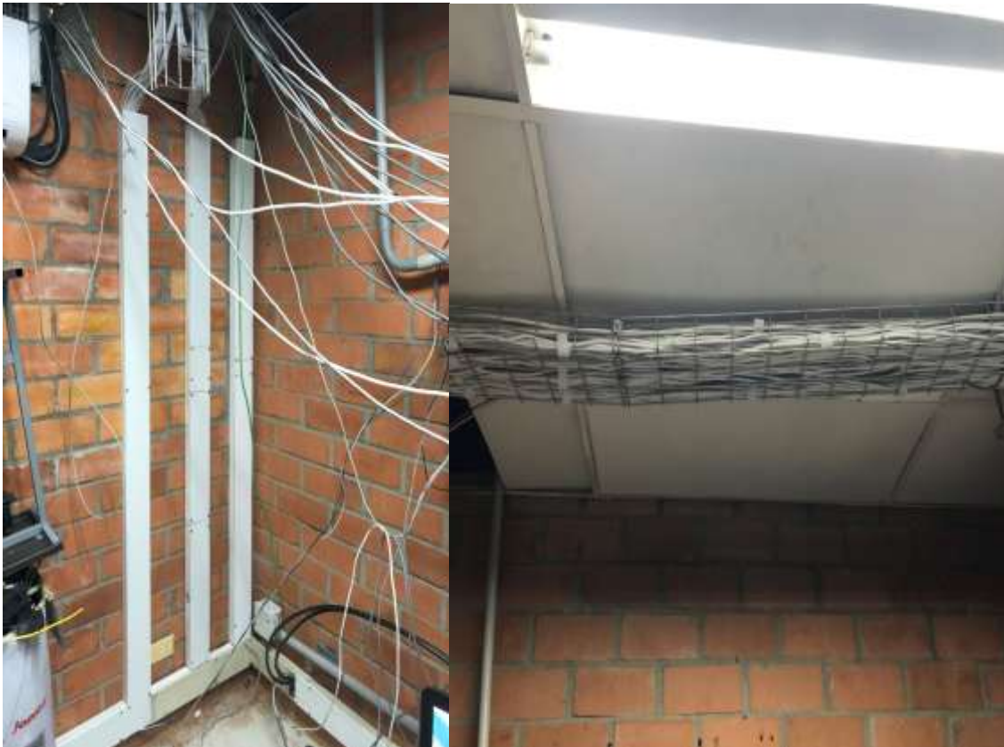
Ilustración 12. Conducción del cableado nuevo hacia el rack
