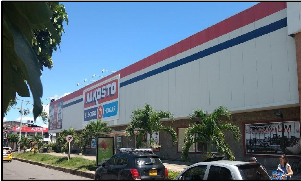
Ilustración 2: Fachada exterior Alkosto sede Yopal. Fuente: Google imágenes
