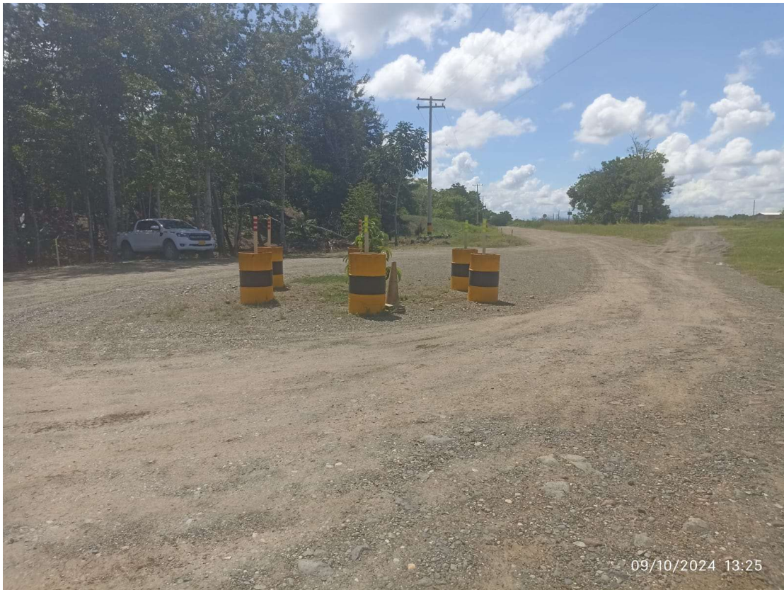
Ilustración 5 Barriles para creación de rotonda vial
