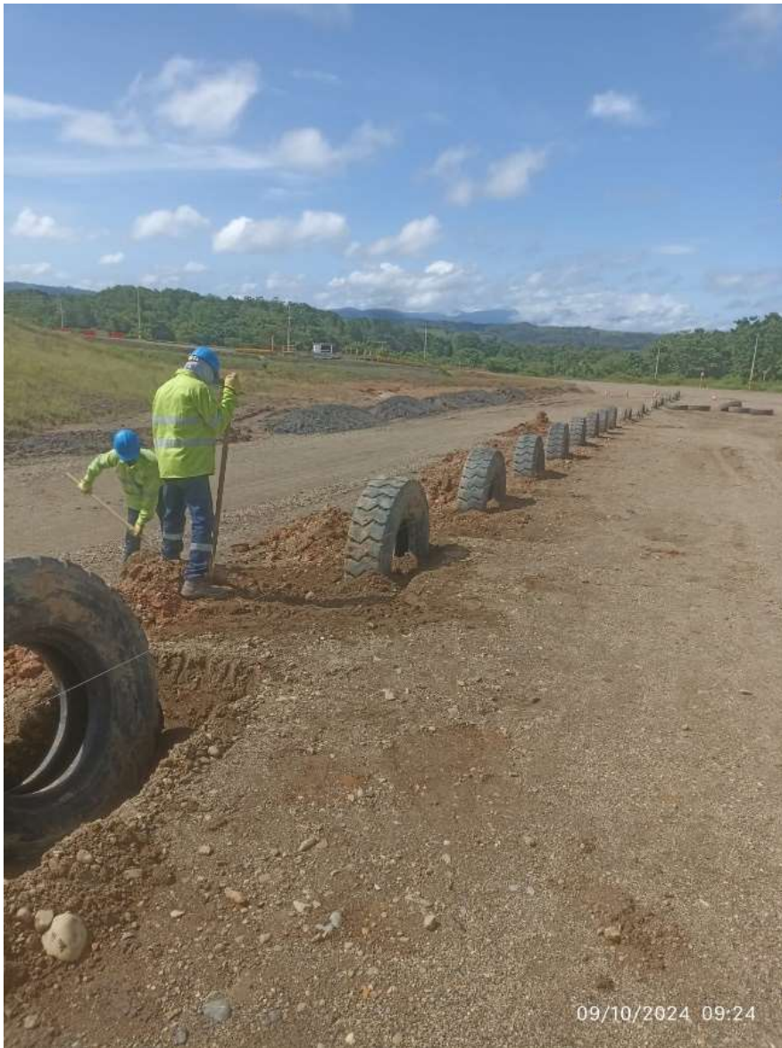
Ilustración 4 Llantas utilizadas para defensa vial
