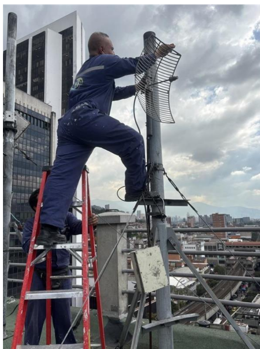
Figura 7. Adecuación para la instalación (Fuente: Propia)
