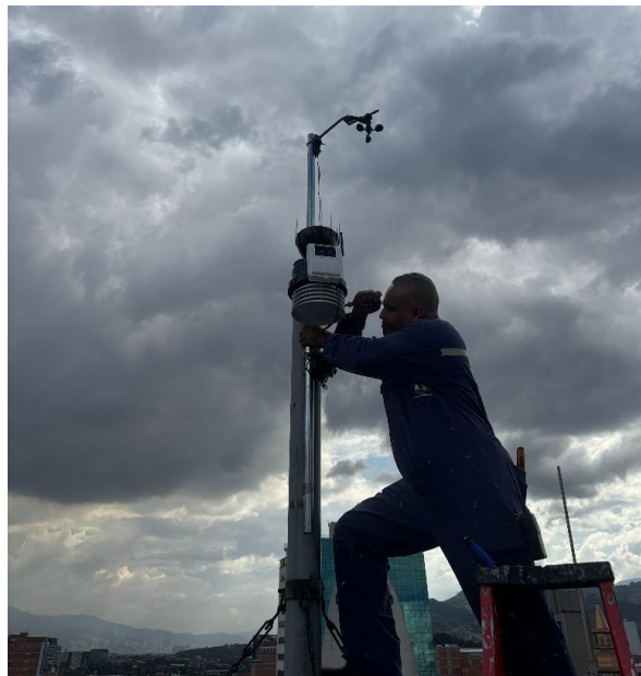
Figura 8. instalación (Fuente: Propia)
