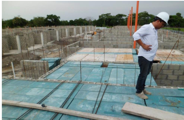
Figura No.07: Entarimado de formaleta plástica para construcción de placas de entrepiso Fuente. Tomada de la web. https://www.plasticosestructurales.com/web/formaletas-plasticas.html
