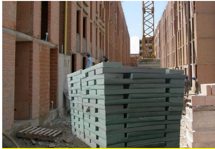
Figura No.05: Formaletas plásticas para construcción de placas de entepiso. Fuente. Tomada de la web. https://www.maderplast.co/11-formaletas-plasticas-0-acabados-estructurales-0-camillas-para-encofrados-de-concreto-0-entibados-0-construccion-moldes-para-concreto-0-construccion-moldes-para-paredes-0-construccion-moldes-para-placas-0-construccion-tecnificada.html
