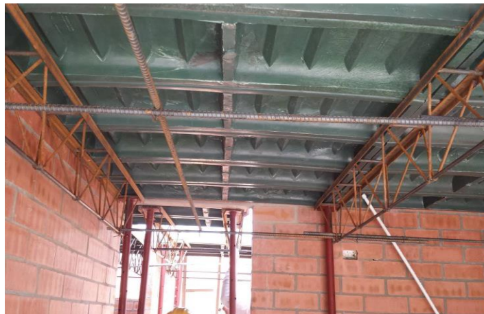
Figura No.06: Proceso de instalación de formaleta plástica para construcción de placas de entepiso. Fuente. Tomada de la web. https://www.plasticosestructurales.com/web/formaletas-plasticas.html
