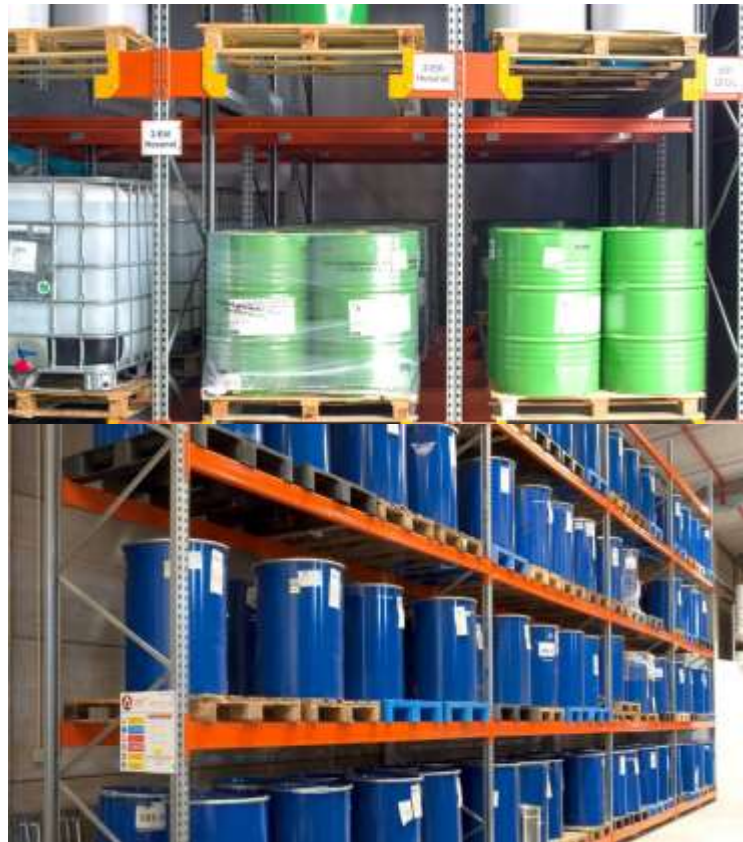
Gráfico 10. Almacenamiento en estantería de acero estructural.
