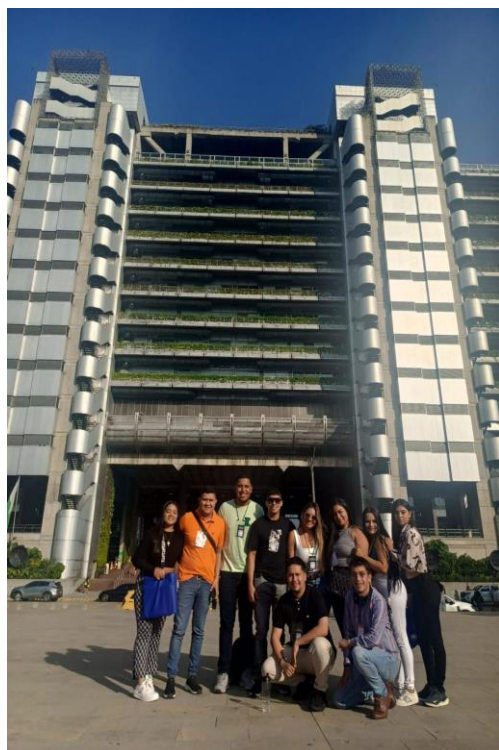
Visita al edificio inteligente EPM
