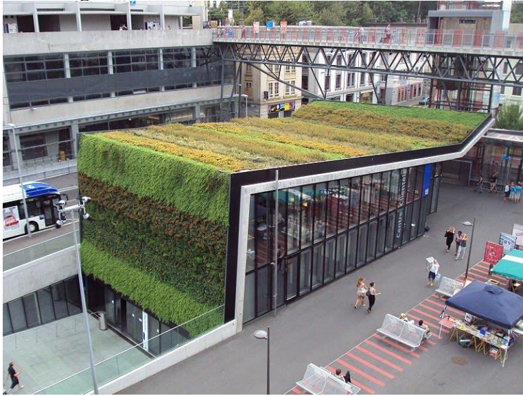
Imagen 3. - Fachadas verdes e iluminación natural
